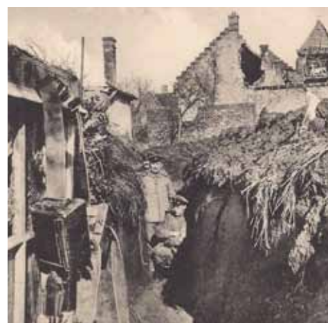
Tranchées allemandes German Trenches
