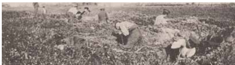
Premières tranchées anglaises English soldiers in the first trenches
