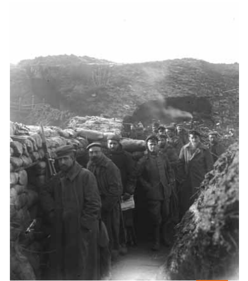
Le froid dans une tranchée.
