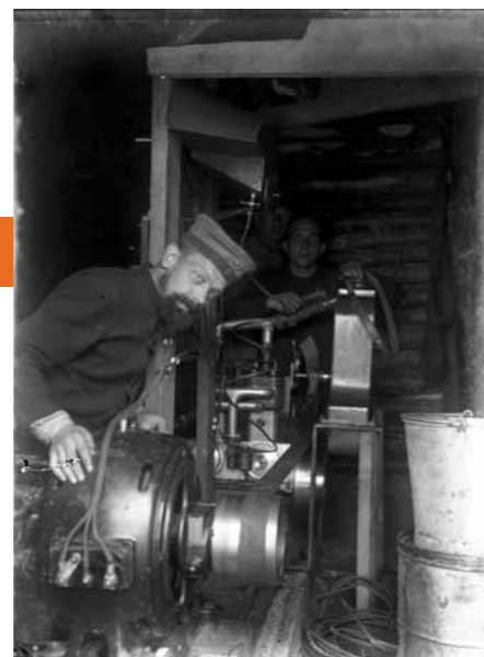
Un groupe électrogène utilisé pour fournir de l'électricité dans un abri.
