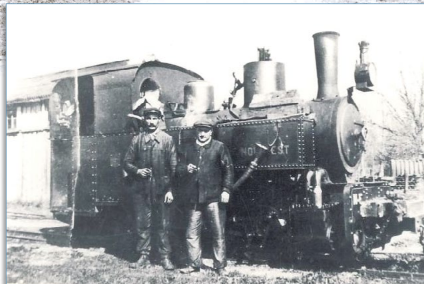
Une 030T Decauville de la vallée de l'Ailette. La Vie du Rail droits réservés.
