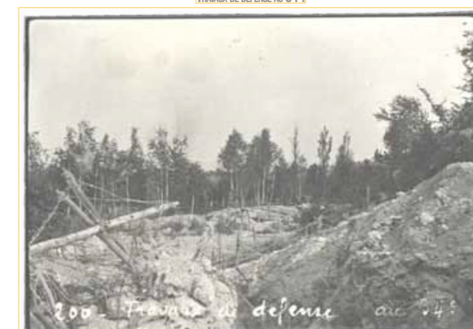
TRAVAUX DE DÉFENSE AU 34°.
