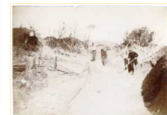
110 - Bois sur Bois Foulon
