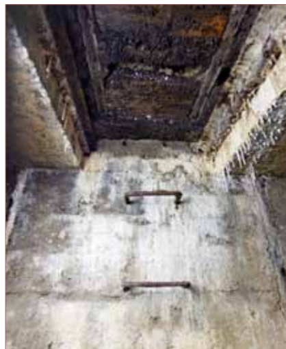
Fig. 7 : Un des deux puits d'accès à l'étage avec ses barreaux d'échelle. Photo © Irwin Leullier
