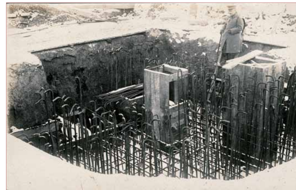
Fig. 12 : Coffrage des espaces internes et montage de l'armature métallique avant le coulage du béton. Cliché réalisé au cours de l'hiver 1916-1917 appartenant au capitaine W. Barthold du 13 e régiment de Landwehr. L'officier que l'on voit sur l'échelle a porté cette légende au verso de la photographie : « Un abri pour mitrailleuse en construction, selon les expériences de la Somme. Indestructible. Tout en béton armé, 5 mètres. » (voir La lettre du Chemin des Dames 23, 2011). Archives Hermann Plote
