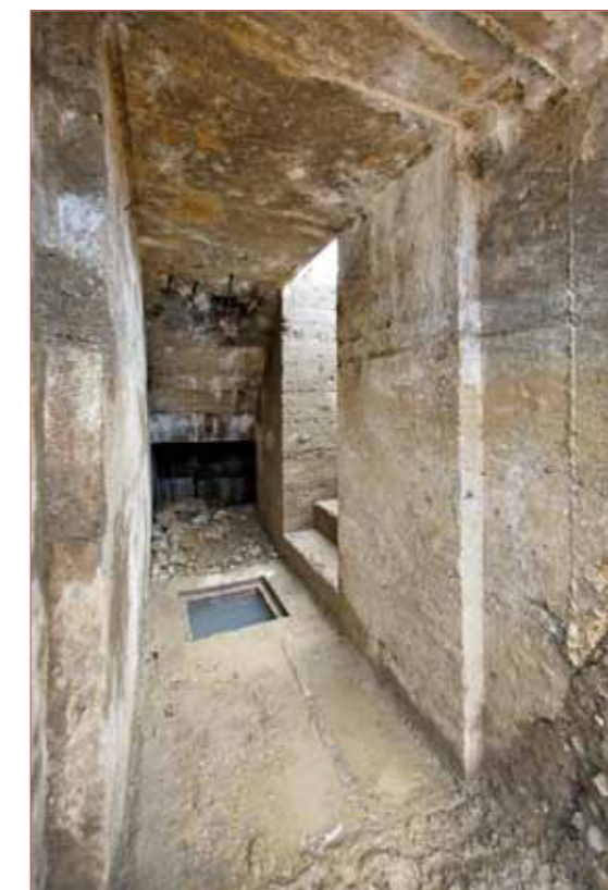
Fig. 6 : Le couloir d'accès, le départ de l'escalier et le puisard. Photo © Irwin Leullier
