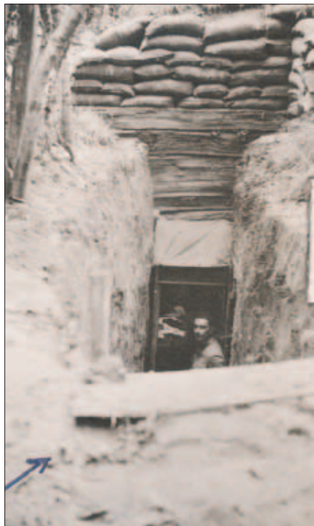
1, 2 et 3. « Position de la batterie, bois des Geais. Berry-au-Bac, juillet 1916. 4. « Mon nouveau gourbi ». 5. « Bois des Geais ».
