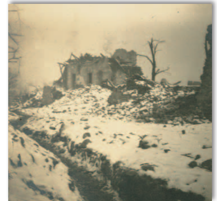
Une tranchée au pied des ruines de la ferme d'Hurtebise. La neige. Hiver 1914-1915. © Collection départementale Caverne du Dragon.
