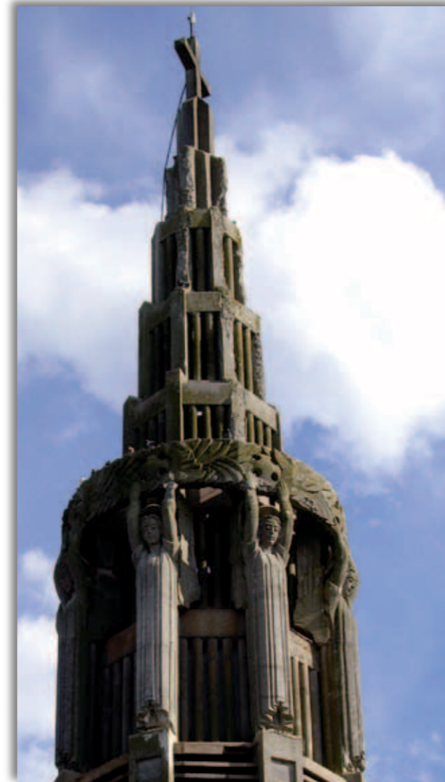
Flèche en béton de l'église de Martigny-Courpierre reconstruite en 1928-1933 par Albert-Paul Müller, architecte. © Caverne du Dragon/CG02.
