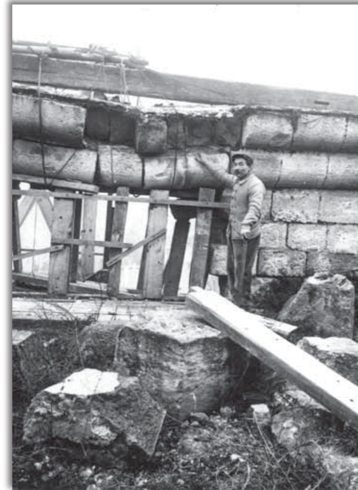
Sur un chantier de la Reconstruction dans le Soissonnais. AD02, Fonds Vergnol, 13 Fi 1319
