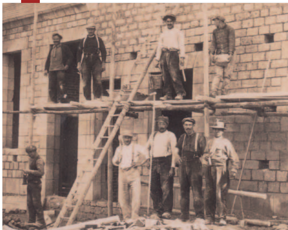
Reconstruction des écoles de Vregny, probablement par l'entreprise Garibaldi. Vers 1923-1924. Coll. A. Potier. Droits réservés.
