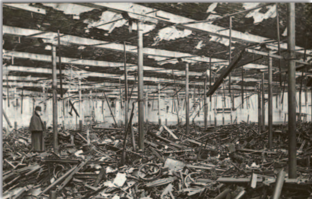
Saint-Quentin, usine en ruines au lendemain de la guerre. FRAD002 22 Fi Saint-Quentin
