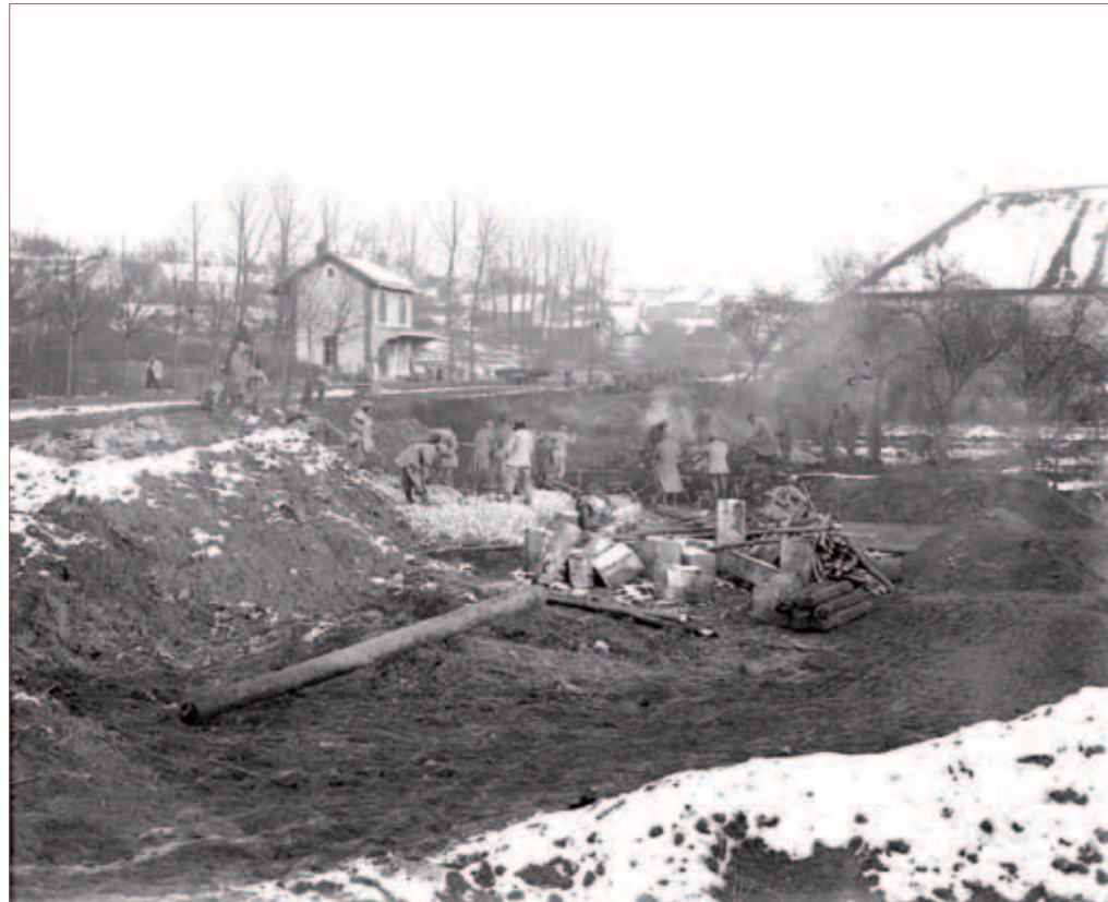
Travaux sur les voies à proximité d'une gare (non identifiée) des chemins de fer de la banlieue de Reims (CBR) dans la vallée de l'Aisne. Coll. Désiré Sic.
